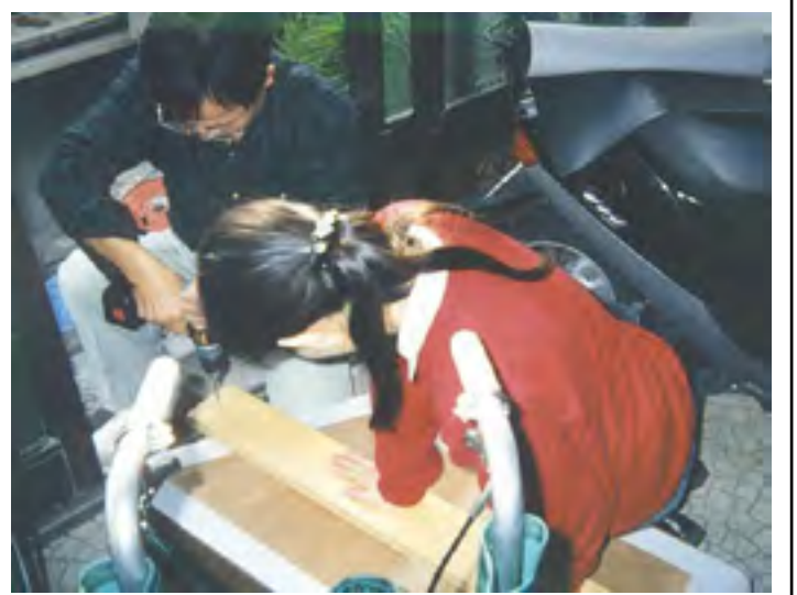
手すりの下地材の下穴あけ
