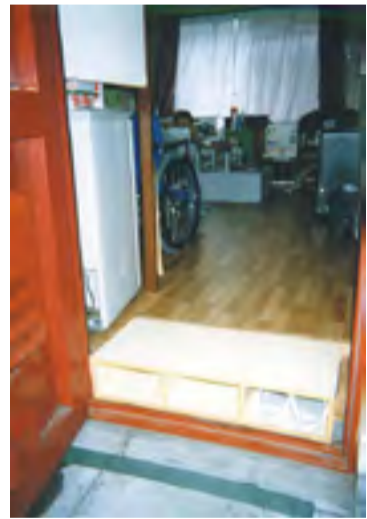
玄関ポーチの段差解消
