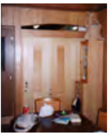
①建具の新設
