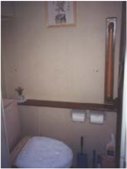
た手スリをはずす。ボード裏に補強板を設ける方法を断念。今度は壁端部
