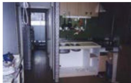
流し台設置 (工事中)
