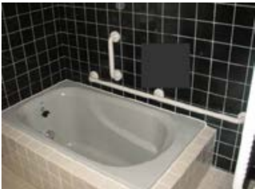
浴室改修後 介護スペースを確保
