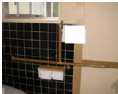
トイレ内手すり
