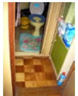
トイレ改修前
