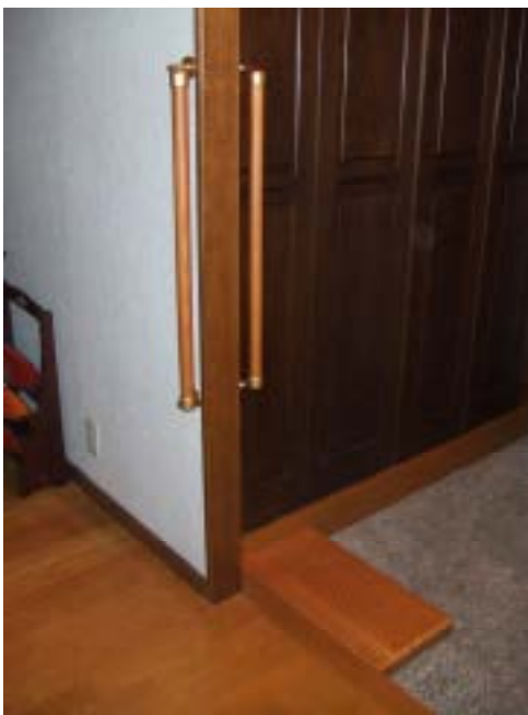
①玄関 木製踏み台設置、手摺取り付け
