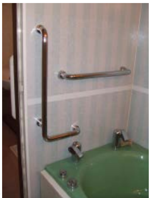
②洗化粧台横にL型手摺取り付け
