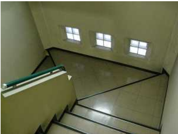
(廻り階段が福祉条例に適合していない)
