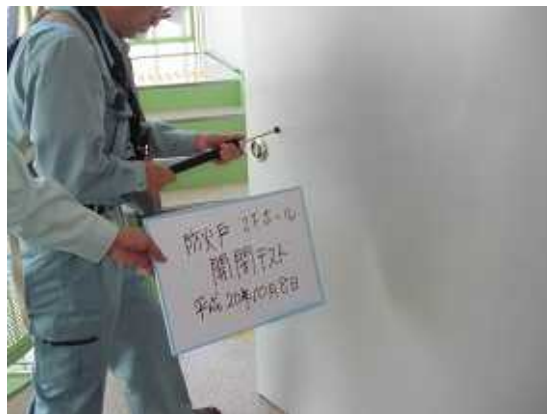
(防火戸の閉鎖力テスト)
