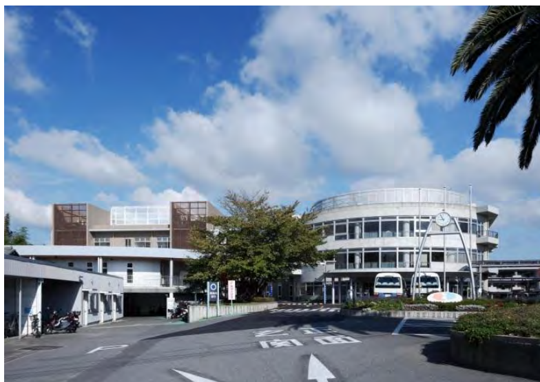
上記写真は「病院案内」パンフレットに掲載されている阪南病院
