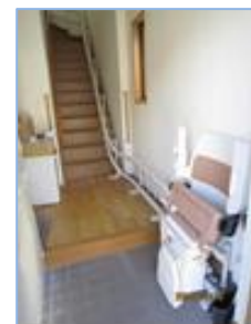
階段昇降機 車いすの利用に配慮して物入の下を空けている
