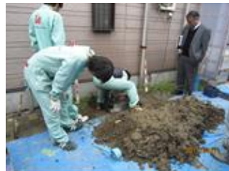
基礎断面を確認中
