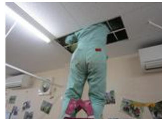
鉄骨断面、取付け状況を確認中
