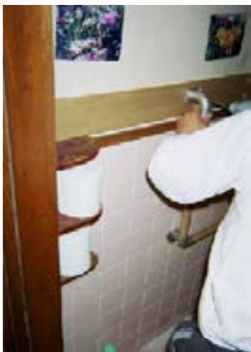
【トイレ手すり取付け作業中】
