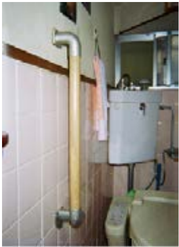
【トイレL型手すり】
